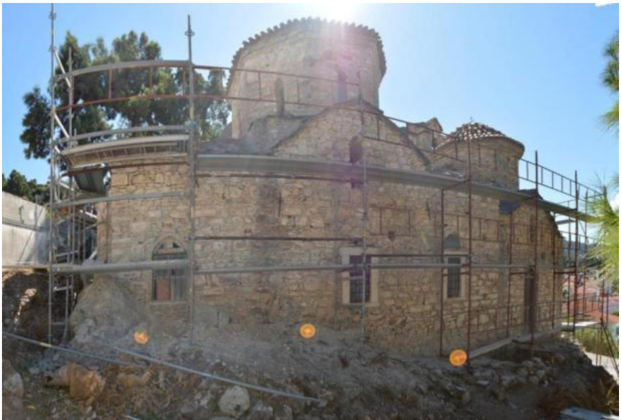
Εικόνα 10: Βόρεια όψη του ναού μετά την έναρξη των εργασιών.
